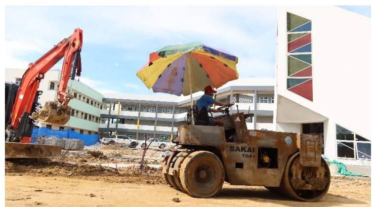
校園填土工程
